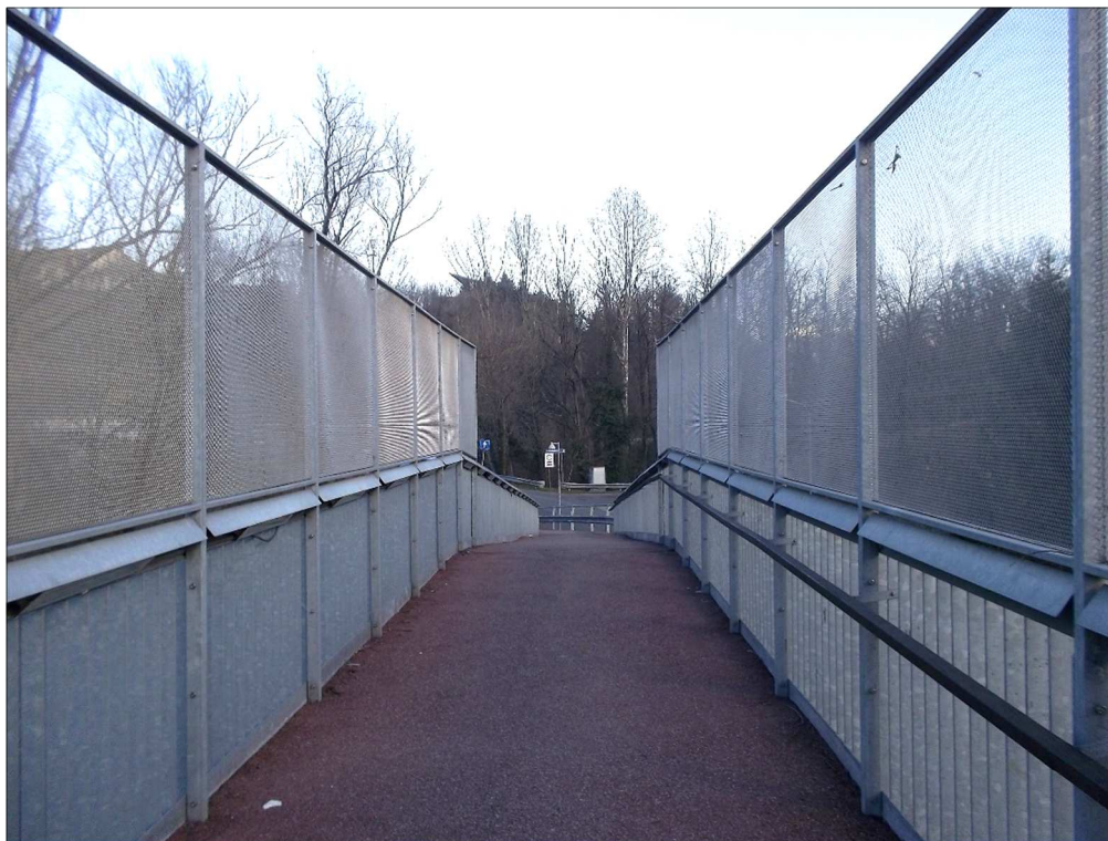
Passerella ciclopedonale sopraelevata su S.P. ex S.S. 342 Como - Bergamo
